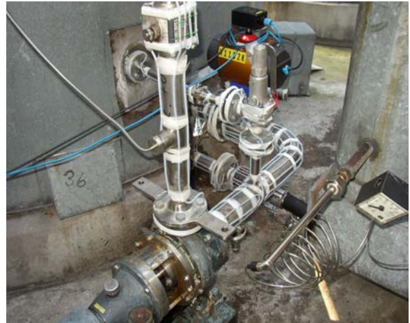
Tankanschluß mit Sicherheitsventil
